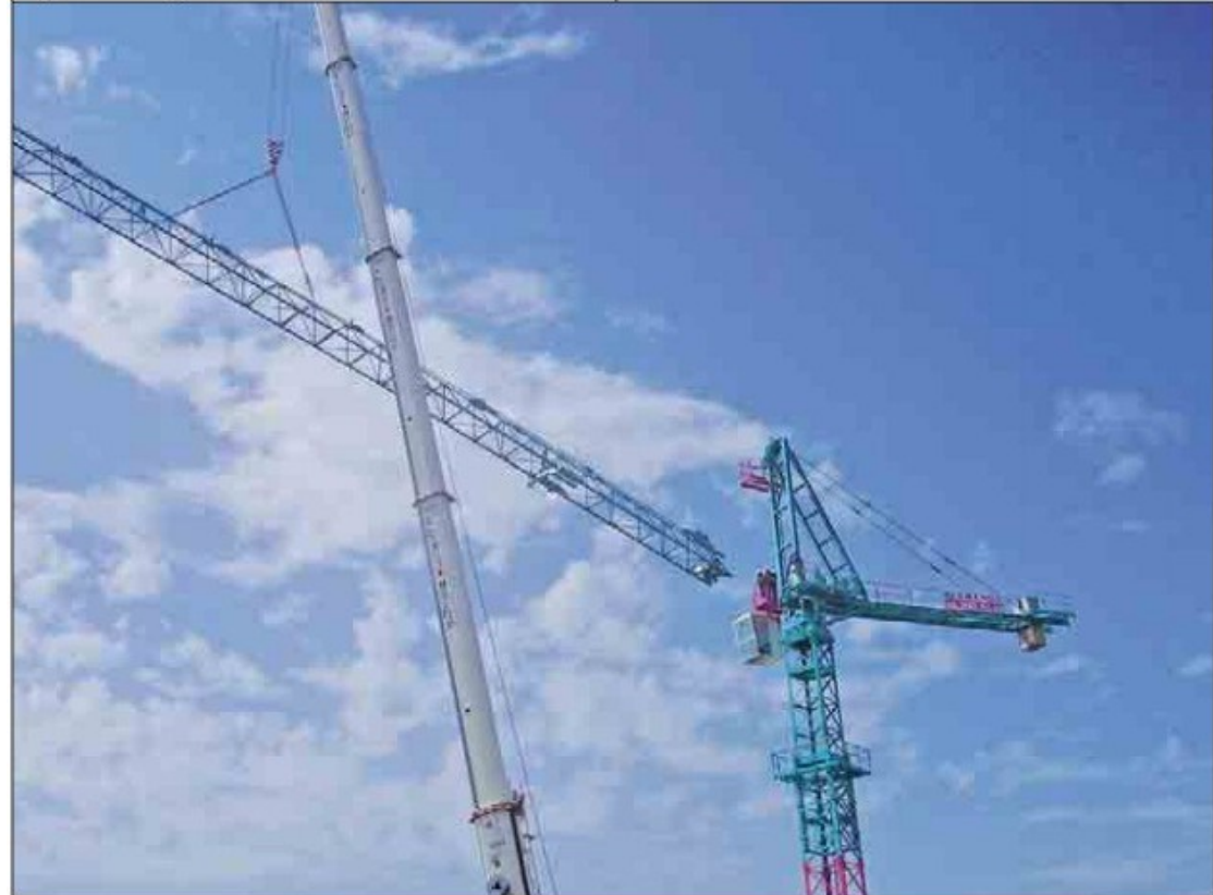
Operatori in posizione defilata in attesa del braccio
