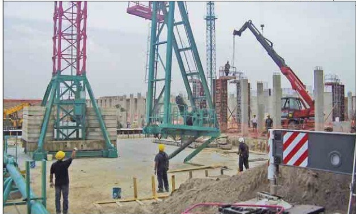
Sollevarmento della cuspide – Sono visibili il ballatoio di servizio e la scala protetta per raggiungerlo
